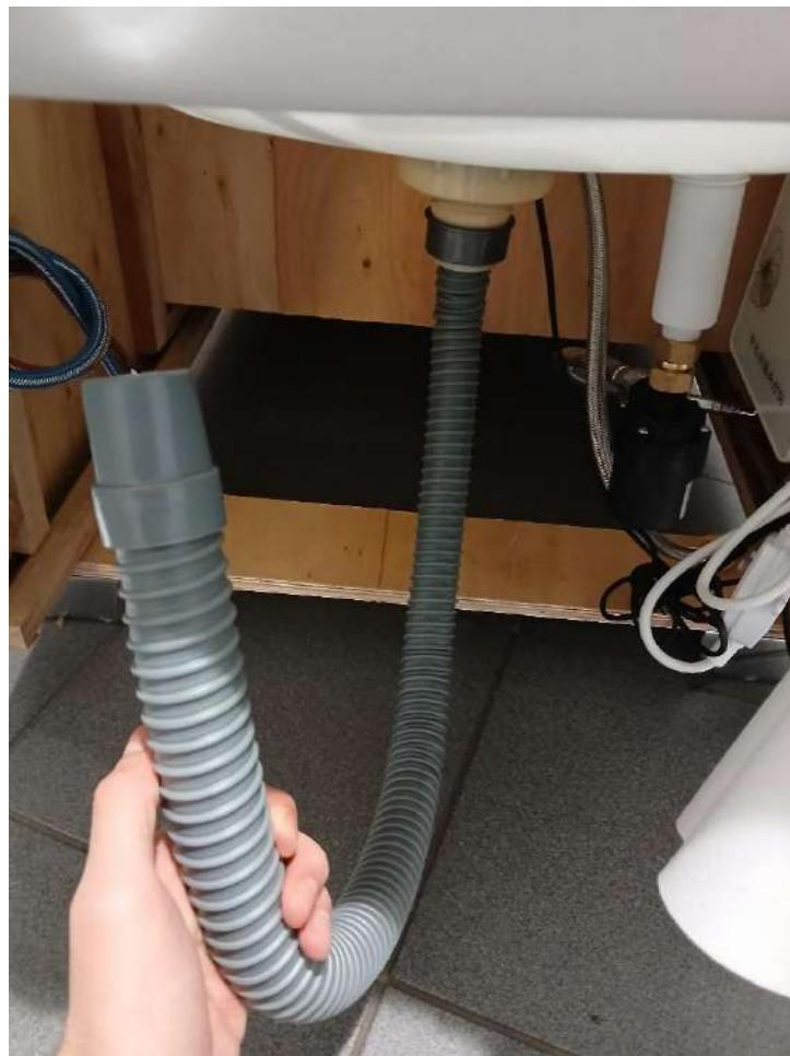
3. Raccordez le tuyau à l'appareil générateur de vapeur comme indiqué sur l'illustration.
